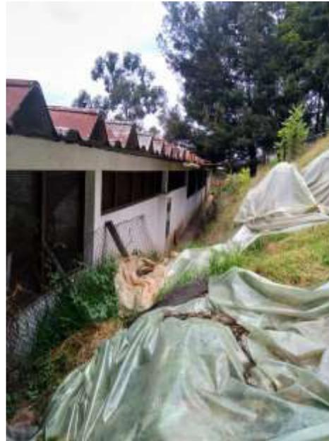
**Fotografía 3-4. Muro oriental de las aulas 910 y 912 y cerramiento perimetral sobre el cual descansa la masa movilizada.**
