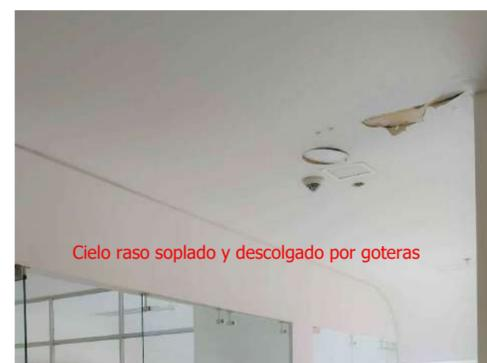
Cielo raso soplado y descolgado por goteras
